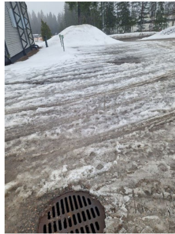
Kuva 2: Sadevesikaivon (myös kuvassa 3) paikka.
